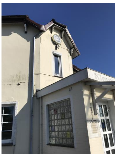
Frontansicht des Haupthauses (Eingangsbereich des früheren Gasthofs)
