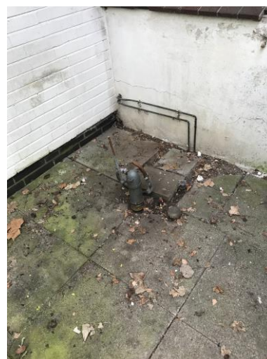
Außenanlage am Haupthaus
