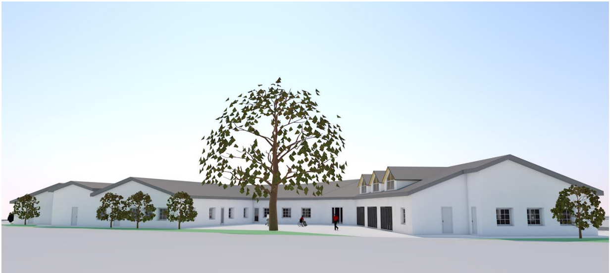
Ansicht aus Richtung Osten auf die innenliegende Freifläche der „Neuen Mitte“
